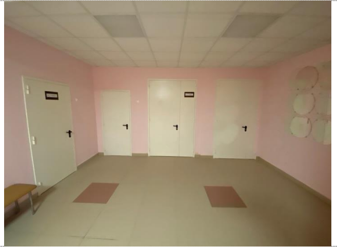
Фото №32 – Пути движения внутри здания (двери)
