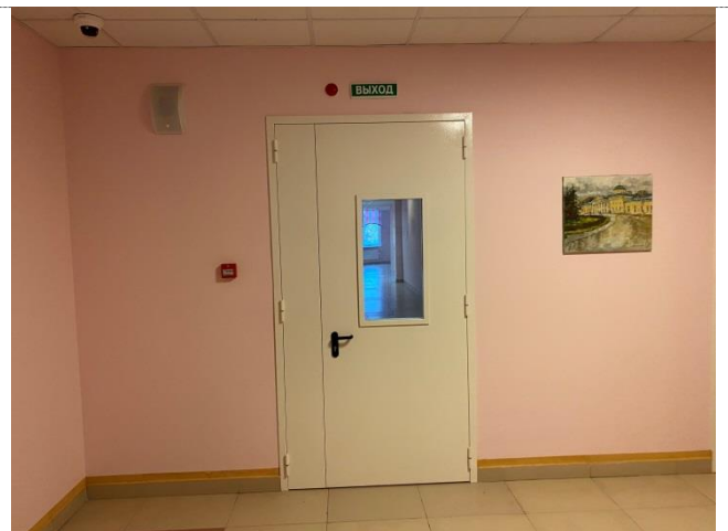
Фото №30 – Пути движения внутри здания (двери)
