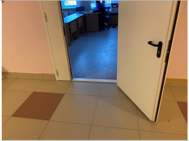
Фото №31 – Пути движения внутри здания (двери)
