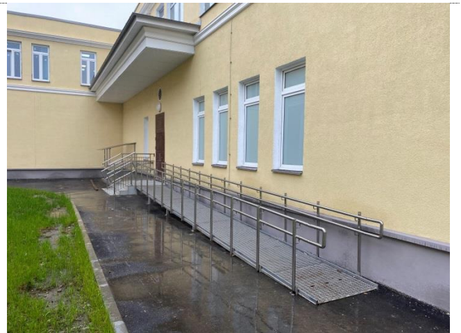
Фото №66 – Запасной выход оборудованный пандусом.
