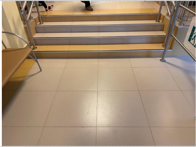
Фото №19 – Пути движения внутри здания (лестницы)
