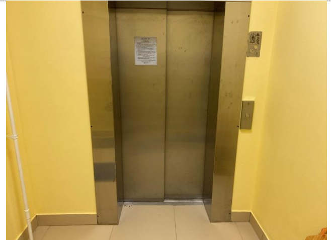
Фото №24 – Пути движения внутри здания (лифт)
