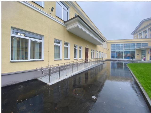
Фото №67 – Запасной выход оборудованный пандусом.
