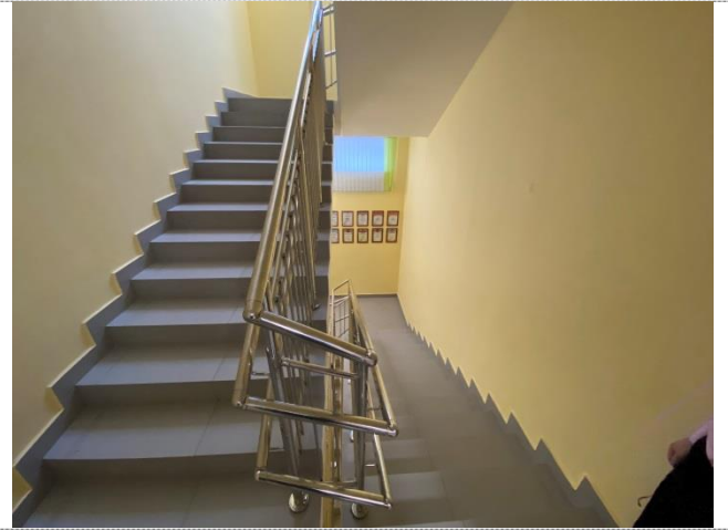
Фото №20 – Пути движения внутри здания (лестницы)
