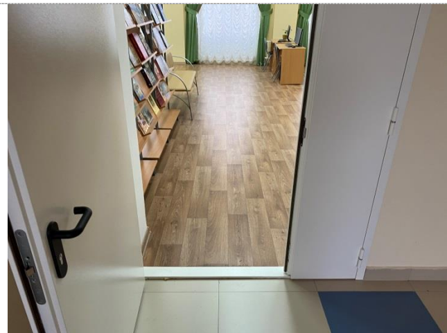
Фото №33 – Пути движения внутри здания (двери)
